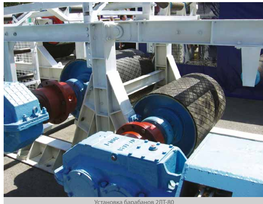
Установка барабанов 2ЛТ-80
